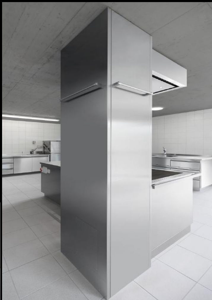
Sloup kompletně obložený nerezovou ocelí
